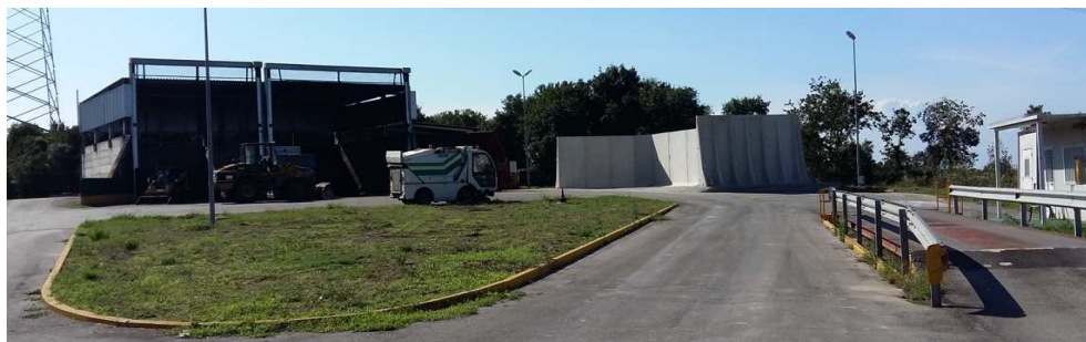
Figura 9 - Impianto stoccaggio rifiuti (organico, sfalci e potature)
