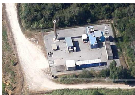
Figura 8 - Ex Impianto Biogas - Torcia
