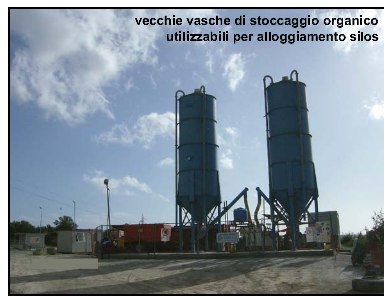
vecchie vasche di stoccaggio organico utilizzabili per alloggiamento silos
