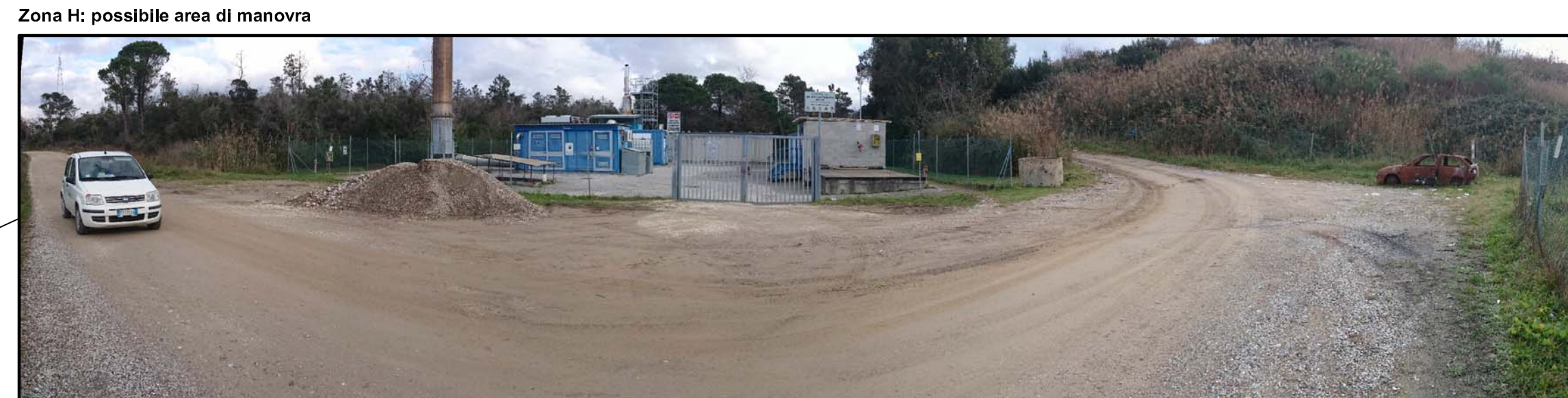
Zona H: possibile area di manovra
