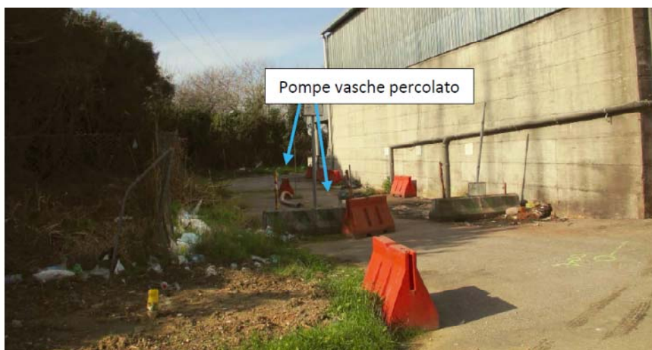
Foto 8 – Sottoservizi zona K-M area stoccaggio organico
