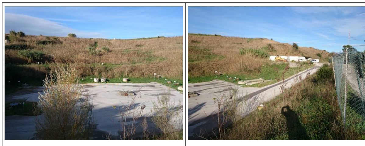
Foto n. 12 – Versante dell'anfiteatro e strada soprastante.
